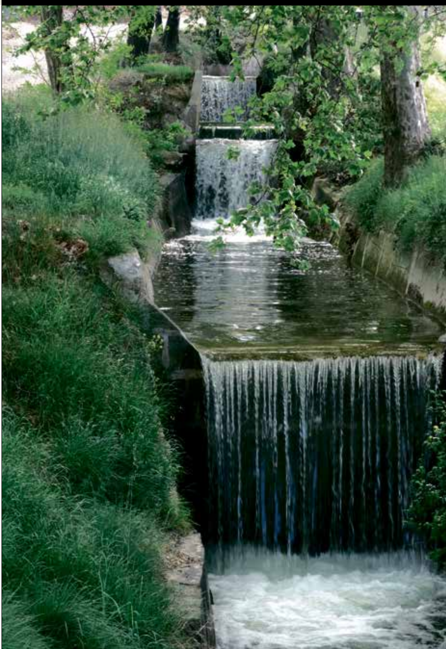
Vista parcial dels 9 salts a la 4a séquia del Canal d'Urgell.
